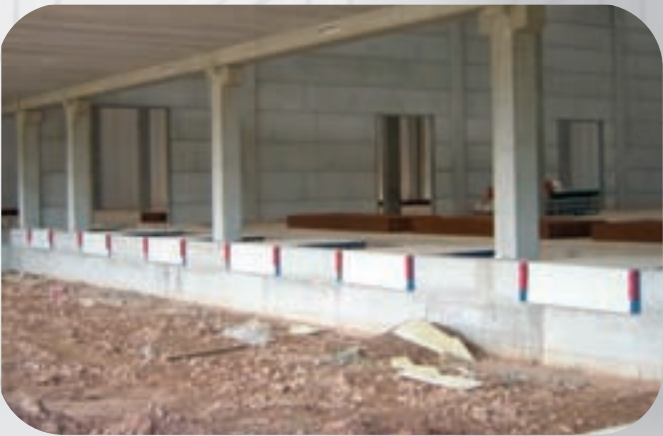
Easy Ramp lista para rellenar con zahorra o encofrar.
