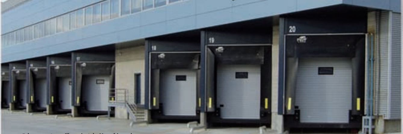
Telesco con trampilla en instalación refrigerada.
