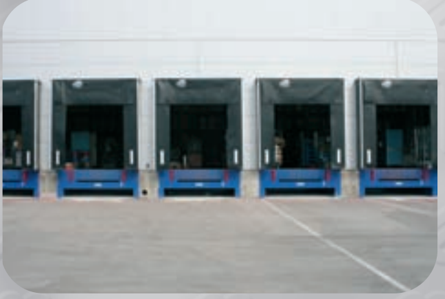
Obra finalizada de Easy-Ramp con trampilla.
