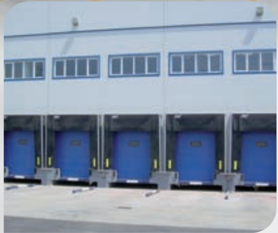
Telesco con trampilla en instalación frigorífica.
