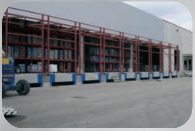
Instalación de Easy-Ramp con trampilla. (Hueco rampa camiones).
