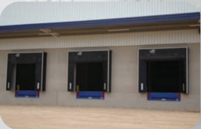
Obra finalizada de Easy-Ramp sin trampilla.
