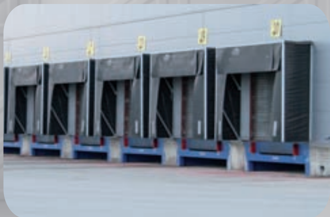
Obra finalizada de Easy-Ramp con trampilla.
