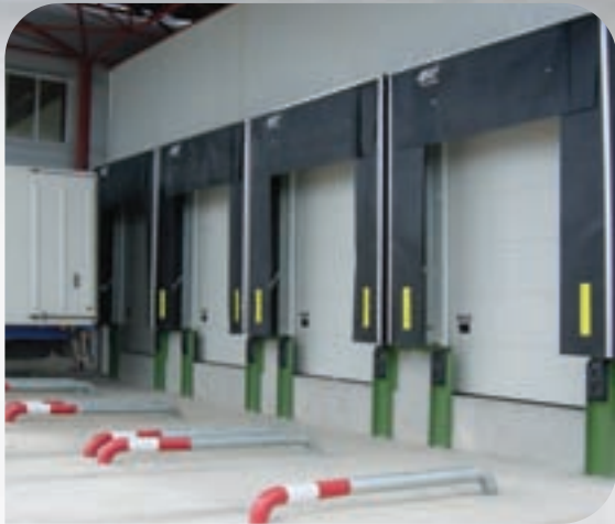
Telesco sin trampilla en instalación frigorífica.
